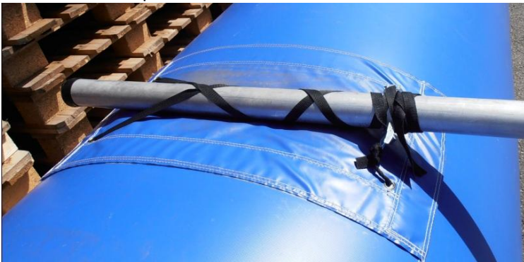
Stangen befestigen
